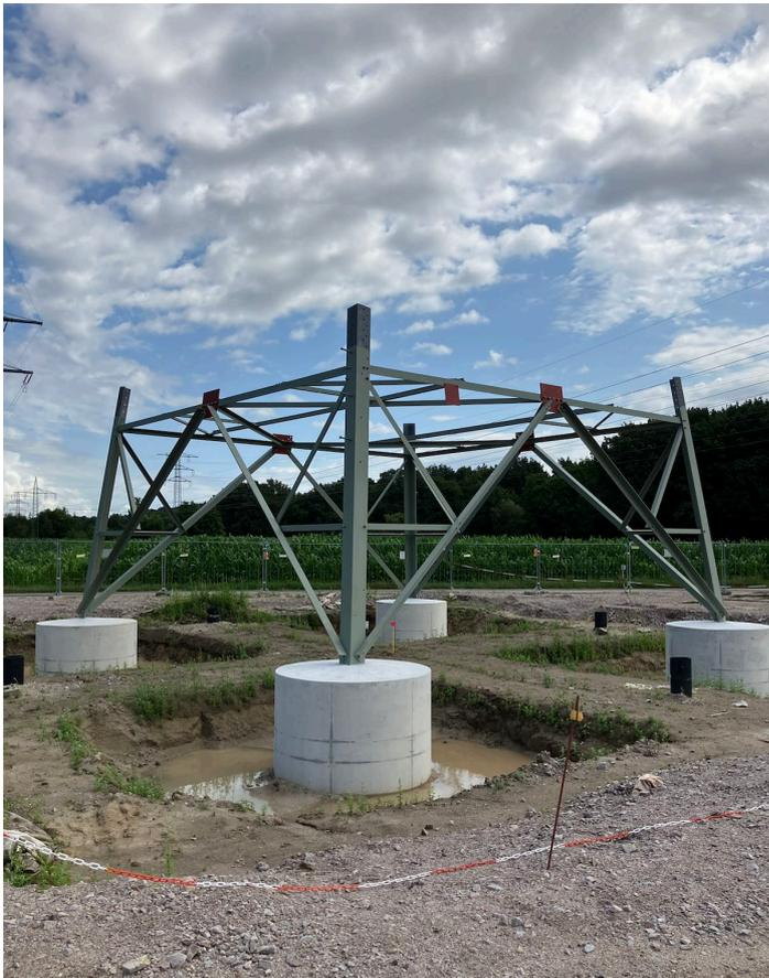
*BU:* Betonage der Mastfundamente von Höchstspannungsmasten. (© ROBUSTA-GAUKEL)
