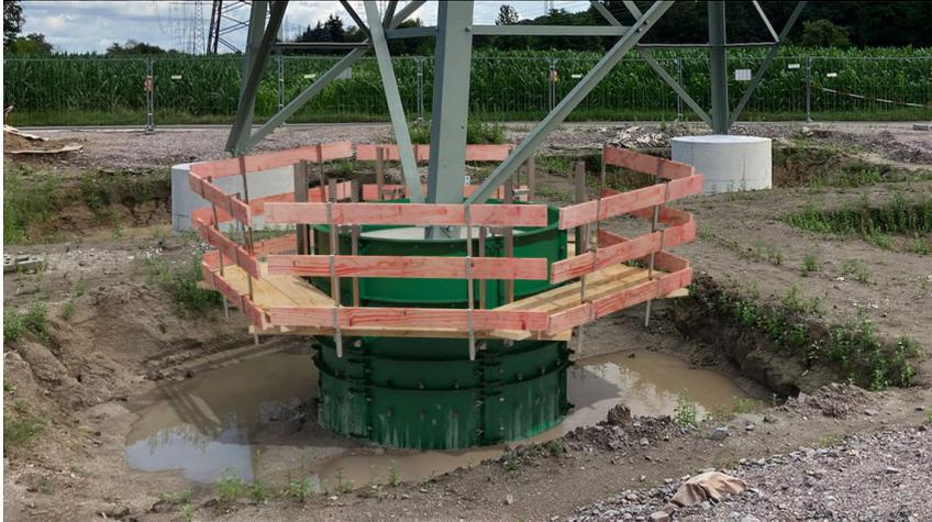
*BU:* Einschalen ohne Hochbaukran: Die Rundsäulenschalung besteht aus sechs Segmenten die händisch transportiert werden zu können. (© ROBUSTA-GAUKEL)
